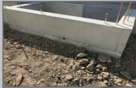
キノ水抜き栓施工後に 入れ子パーツを外した様子
