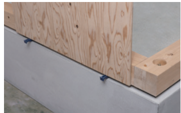
キンスペーサーショートウエイトタイプ(KSW-100A)GSP施工の様子
