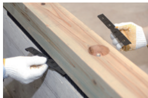
NKSL91-100用レベル調整プレート (LP200-1)施工の様子
